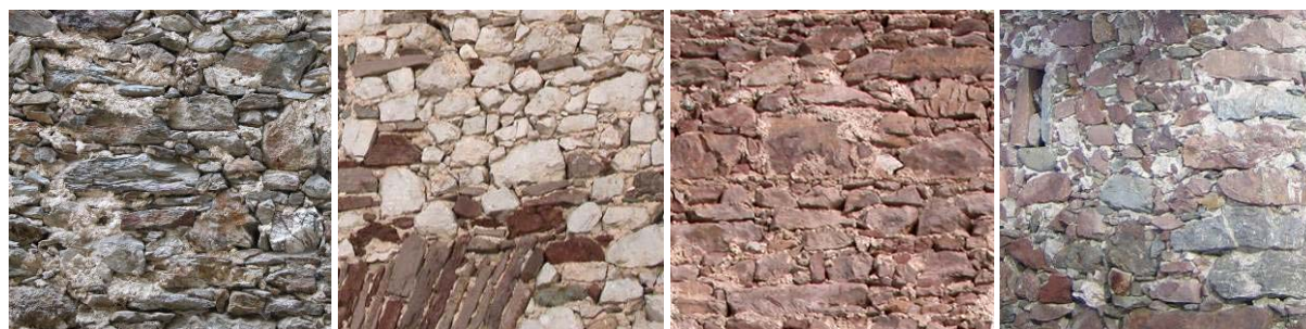
Foto 7: Diversi muri di sassi in Comelico. Da sinistra: muro di scisti, muro di sassi calcarei, muro di sassi porfirutici rossi e verdi. Si noti come anche la malta assume colorazioni diverse per l'uso di sabbie diverse.
