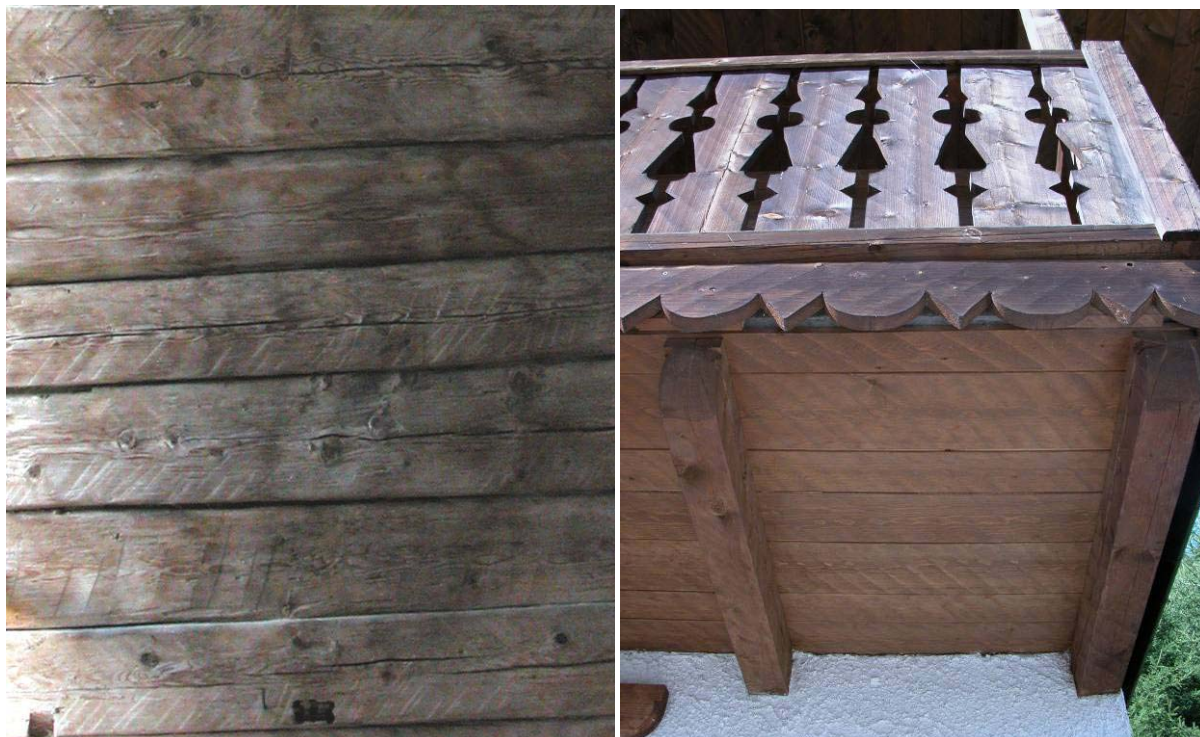
Foto 9: I segni lasciati della lama della lada sulle pareti delle travi squadrate a mano sono molto apprezzati esteticamente, tanto da essere imitati con particolari lavorazioni meccaniche. A sinistra travi squadrate a mano, a destra l'imitazione meccanica della squadatura a mano usata indiscriminatamente (anche sulle tavole!) in una casa di legno demolita e ricostruita a Dosoleto, Comelico Superiore (foto A. Turato).
