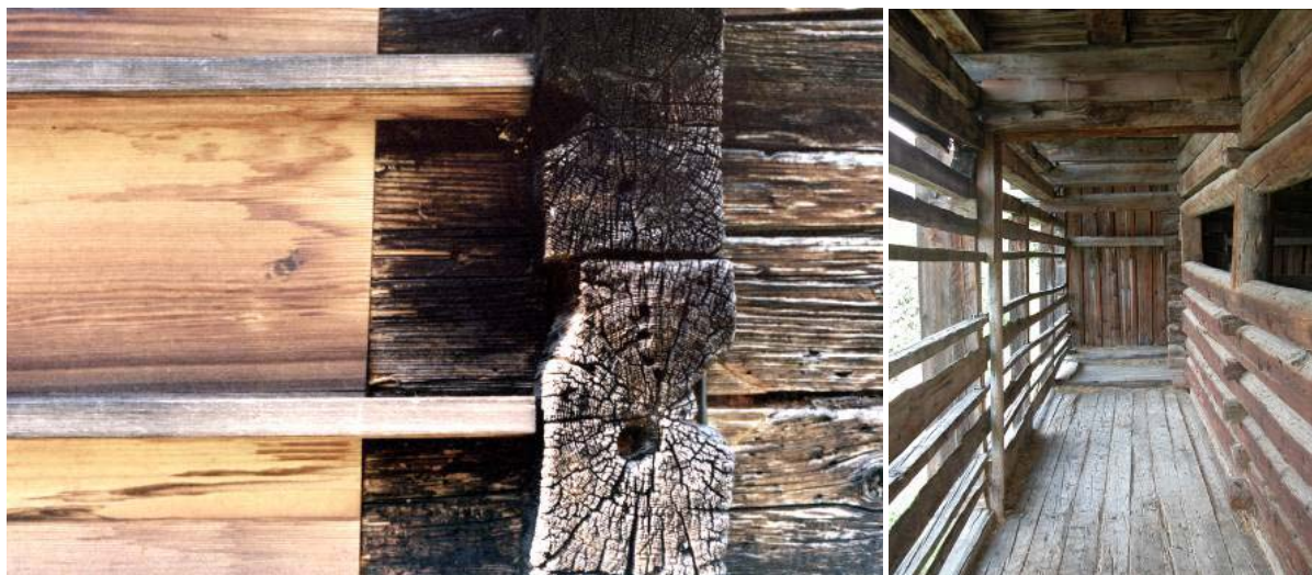
Foto 4: Accostamento di una struttura nuova ad una struttura tradizionale in block-bau che non ne compromette la conservazione integrale (arch. P. Zumthor, foto A. Turato, 2001). Esperimento di aumento della luminosità interna su un tabià in blockbau che consiste nella rimozione di una ampia porzione di una sola trave del castello. Questo intervento si distingue per la limitazione della perdita di materiale storico e per il tentativo di controllo dell'impatto figurativo. A queste buone intenzioni non corrisponde però altrettanta comprensione del funzionamento strutturale del tabià , come dimostra il precario inserimento del montante a destra in primo piano (foto V. Ferrario, 2002)
