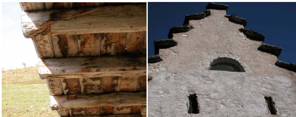
Foto 6: Riparazione delle teste delle travi di un ballatoio ligneo in un tabià in Comelico, tramite sostituzione parziale (foto V. Ferrario); ripresa di un intonaco storico sulla muratura di una casera nel Sovramontino (foto D. Zannin)
