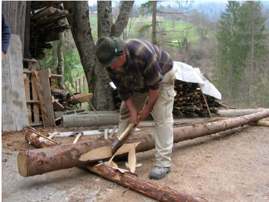
Foto 15: Si inizia fissando con appositi ganci in ferro (clamere) il tronco da lavorare ad altri tronchi disposti trasversalmente che fungono da appoggio. Il filo che fornisce la misura si fissa con due chiodi alle estremità.
