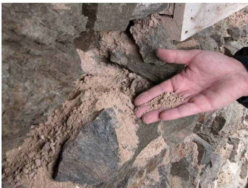
Foto 11: Malta di alletto di un muro di sassi, molto decorsa, a causa dell’impasto povero di legante (foto V. Ferrario)
