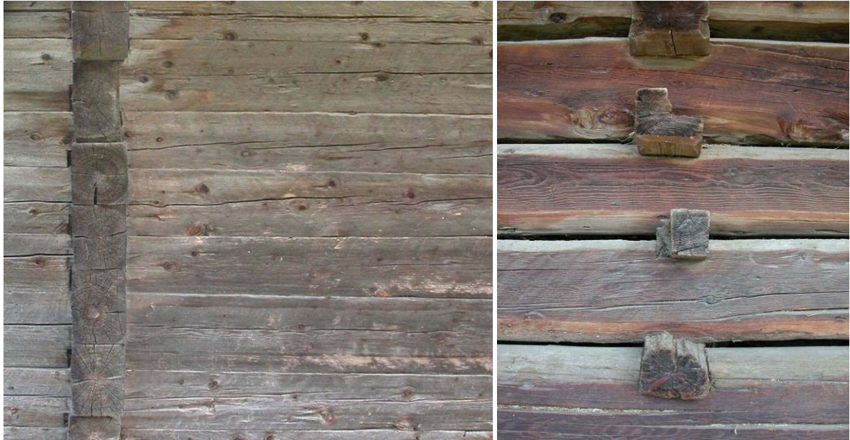
Foto 8: Diverse squadrature per parti diverse di uno stesso tabià . A sinistra parete dell' éra , a destra del pian dal fen (foto A. Turato 2003)
