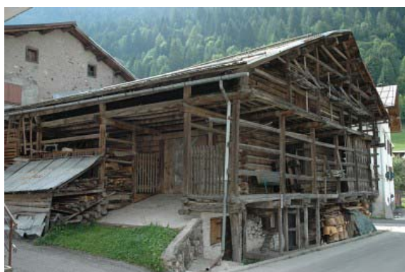
Foto 202 e 203: Celat (San Tomaso) e Canale d'Agordo: la costruzione "terrapieno" presenta spesso raccordi contenuti e pendenze poco accentuate. La troviamo prevalentemente sul lato nord, in corrispondenza dell'appoggio dell'edificio controterra, ma anche sui lati del tabià, in relazione alla distribuzione interna ed all'ubicazione.
