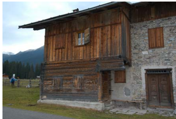
Foto 81: Prà Marino (Val Vissdende): “Strutture” miste “a castello” , “a ritti e travi”. Esempi della Val Vissdende di compromissione tra le due tipologie costruttive, a castello negli angoli, a ritti in corrispondenza delle aperture o nel caso di riprese di angoli o intersezioni interne.
