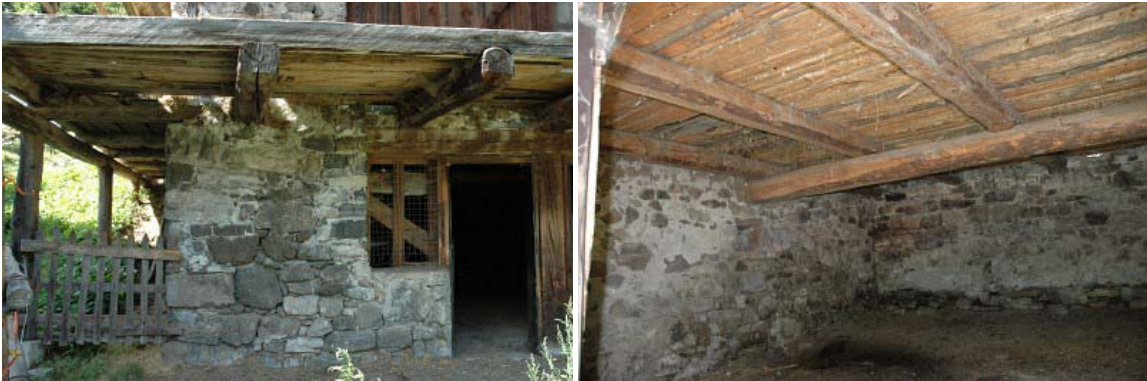
Foto 133: Gares (Canale): un fienile ottocentesco con struttura della muratura a “setti angolari” documenta un solaio a orditura semplice, con le teste che fuoriescono a formare il ballatoio nel senso dell’orditura; un rompitratta centrale interrompe la luce libera del solaio. Le teste sono ammorsate direttamente nella muratura.
