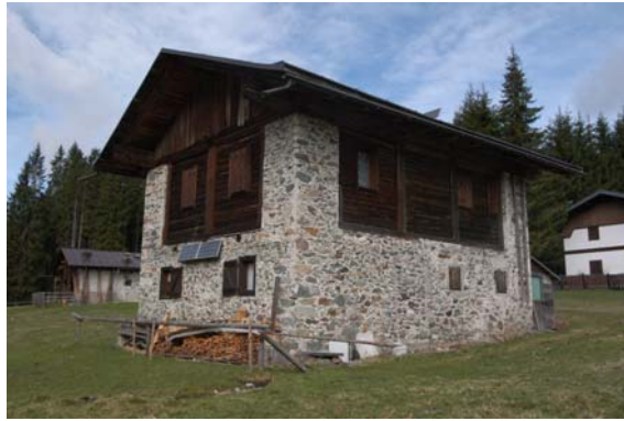
Foto 6: Nel caso in esame (Costa d'Antola in Val Vissende) secondo gli orizzontamenti dei solaio: il piano terra: muratura con aperture;
