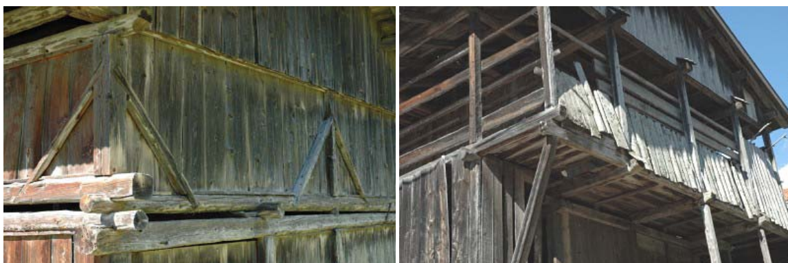
Foto 91: Feder (Canale) e Feder (Canale): ciò che caratterizza il tabià a “colonne controventate” dal tabià “a telaio” sono quasi sempre le trabeazioni orizzontali binate (o trinate) con gli angoli “a castello” (foto a sinistra), cosa che non avviene nelle strutture successive “a telaio” (foto a destra).
