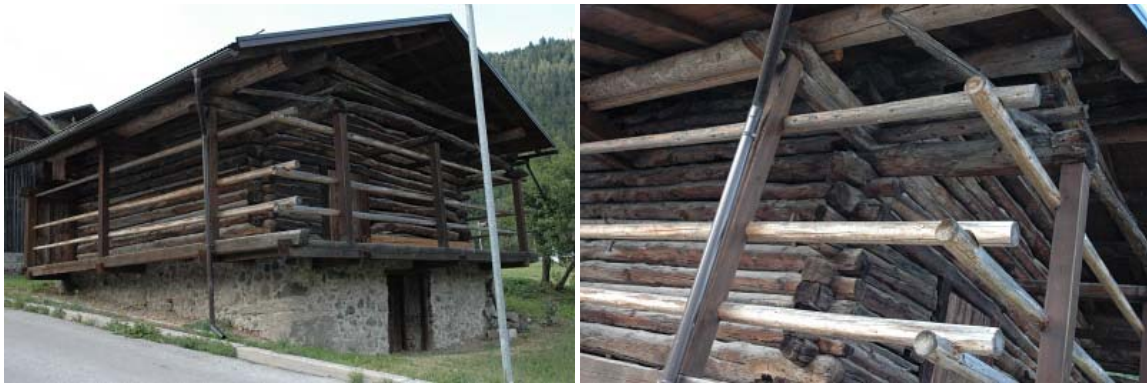
Foto 96: Tabià "a castello" (Celat) con "struttura" "Kolondiéi" alta un solo piano.
