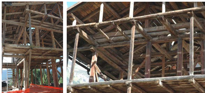
Foto 185: Feder (Canale): sistema costruttivo dell’orditura della copertura “ad arcarecci”, con l’integrazione innovativa delle “capriate”. Sul prolungamento delle travi del solaio, il grande sporto anteriore è sostenuto da una gabbia esterna “a colonne”.
