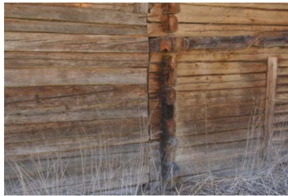
Foto 32: Prà del Belf (Val Vissende) Un esempio non “coerente” di ampliamento a ridosso di un giunto angolare di un edificio “a castello”.
