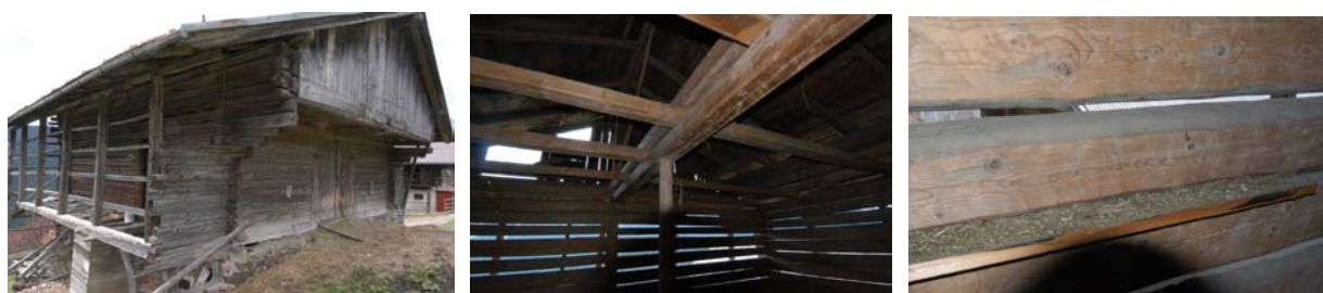
Foto 44: Costa (San Nicolò): esempio dell'utilizzo di travi squadrate aperte
