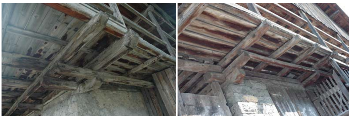
Foto 149 e 150: Sacchet (Vallada) e Canale d’Agordo: La realizzazione del ballatoio talora impone una o più integrazioni alla struttura del solaio.
