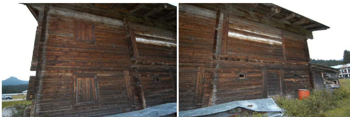
Foto 140: Prà Marino (Val Vissdende): “Struttura” completamente in legno dove il solaio della stalla è trattato in modo differente rispetto al solaio dell’abitazione, denunciando così la funzionalità del “vano” e, al tempo stesso, la sua manutenzionabilità
