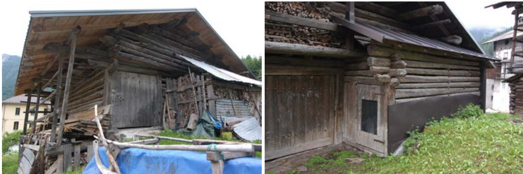
Foto 41 e 42: Vallada e Falcade: esempi dell'utilizzo di travi testa-coda
