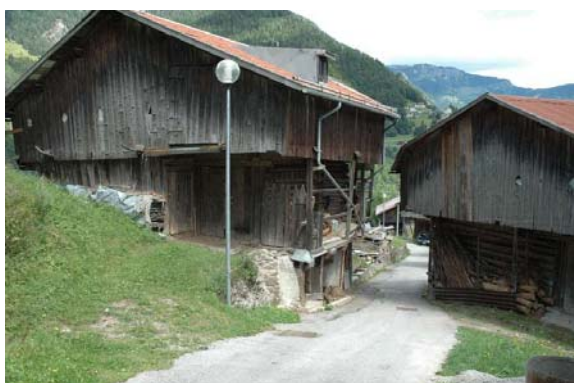
Foto 202 e 203: Celat (San Tomaso) e Canale d'Agordo: la costruzione "terrapieno" presenta spesso raccordi contenuti e pendenze poco accentuate. La troviamo prevalentemente sul lato nord, in corrispondenza dell'appoggio dell'edificio controterra, ma anche sui lati del tabià, in relazione alla distribuzione interna ed all'ubicazione.
