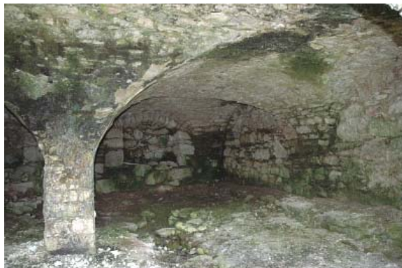
Foto 143: Costoia (San Tomaso Agordino): Esempio di solaio tra la stalla ed il fienile realizzato con volte a botte in pietrame poggianti sulle murature perimetrali e su pilastri nella parte centrale.
