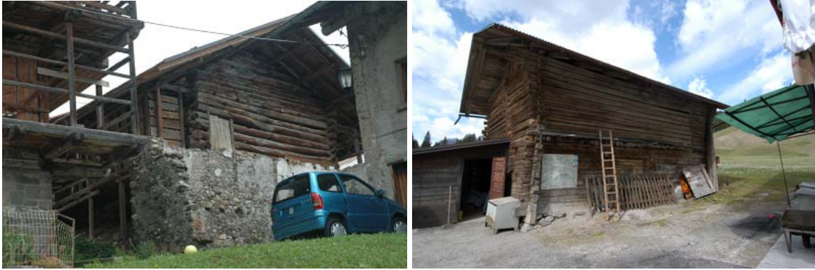
Foto 9 e 10: Negli edifici con “alzato” in muratura-legno (Cogul) e solo legno (Costa d’Antola) la differenziazione verticale della “struttura” fa comprendere la destinazione d’uso originale del fabbricato. Nelle strutture tutto legno, il piano terra adibito a stalla presenta una lavorazione delle travi diversa da quella dei piani superiori
