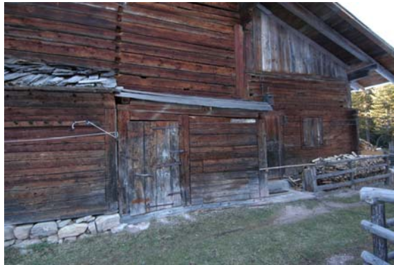
Foto 85: Prà della Fratta (Val Visdende):La tipologia “a ritti e travi” facilita integrazioni all’edificio principale, come dimostra questo tabià della Val Visdende.
