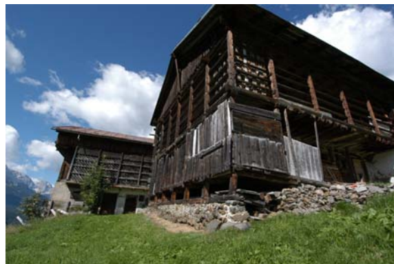
Foto 98: Un tabià di Costalissoio: Gli aggetti ottenuti con la completa estensione del solaio (lato est ed ovest) e partono dal terreno sul lato sud, per recuperare all'uso anche il dislivello esistente al piano terra.
