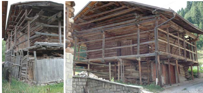
Foto 151 e 152: Carfon (Canale): Struttura ballatoio su un piano, tipica degli antichi tabià “a castello” della Valle del Biois
