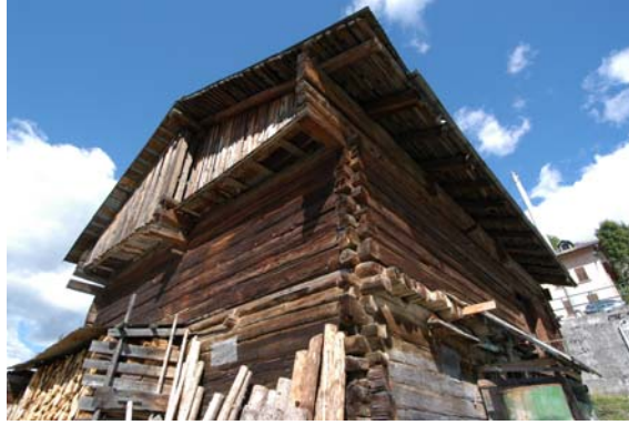
Foto 188: Costalissoio (Santo Stefano): Tabià “a castello” : il colmo è sostenuto da un puntone appoggiato alla “struttura” del solaio. La soluzione consente di risparmiare legname nella costruzione.
