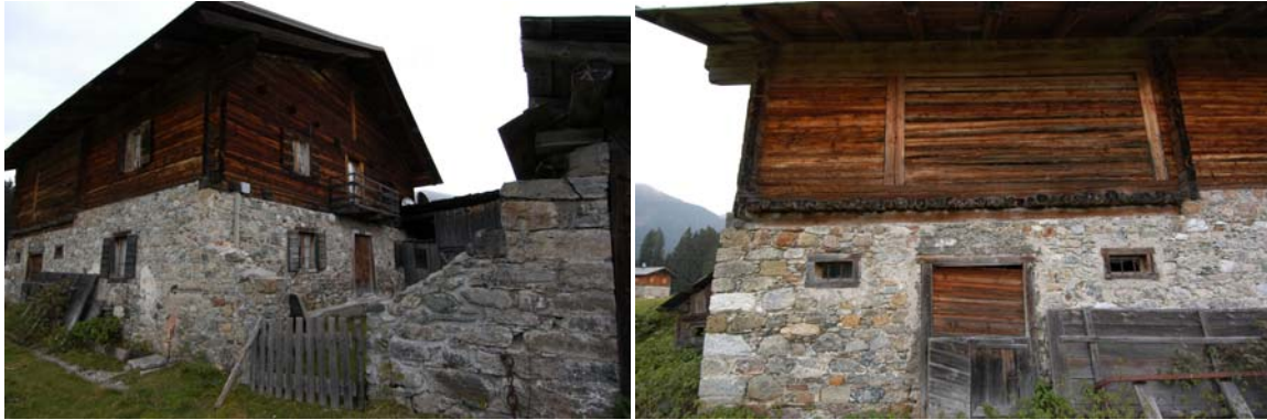
Foto 135: Diversificazione del solaio in un tabià antico di Prà Marino (Val Visdende), dove la parte abitativa viene trattata in modo diverso rispetto alla parte produttiva: la stalla è delimitata da una struttura solaio “a panconi”, appoggiati non sulla muratura ma su un “dormiente”. Tale tipologia costruttiva consentiva (consente) la manutenzione puntuale, trave per trave, della struttura del solaio, che risultava facilmente soggetto a deteriorarsi per l’alta umidità della stalla. La stessa tipologia non è necessaria nell’abitazione.
