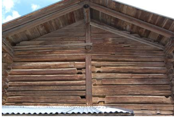
Foto 56: Costa d'Antola (Val Vissende): la storia costruttiva della “struttura” evidenzia come il legname utilizzato sia di “recupero” di un edificio in origine molto più piccolo e, grazie alla tecnica dei “ritti e travi”, esteso con lo stesso.
