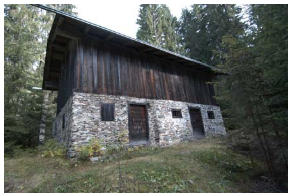
Foto 111: Costa Zucco – struttura a telaio – tavole esterne, nessuna apertura, su corpo base in muratura.
