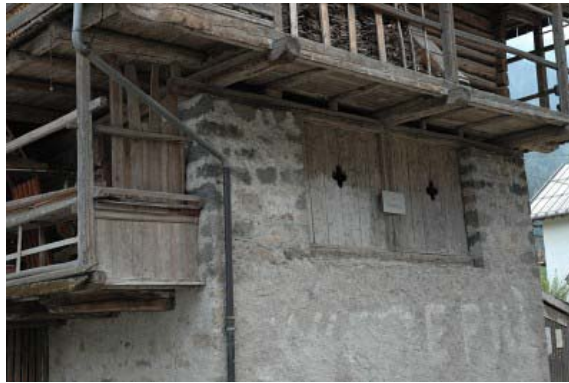
Foto 17: Canale d'Agordo: il secondo ballatoio, realizzato sul prolungamento delle travi del solaio, con quella centrale sostenuta dalla “colonna” in legno e dall’anello superiore che chiude la muratura. L’angolo è realizzato secondo linee parallele all’orizzontamento del solaio; non erano mai usate travi in diagonale.
