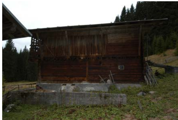
Foto 33: Costa Zucco (Val Vissende) Un esempio di sistema “misto” con i giunti angolari a blockbau e quello centrale a “ritti e e travi”, che consentiva di raggiungere dimensioni consistenti dei tabià, indipendentemente dalla lunghezza del legname a disposizione.
