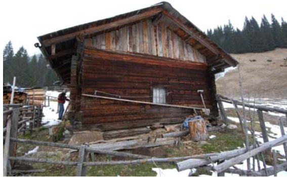
Foto 119: Un tabià di Prà Stavel (Val Visdende): sono immediatamente visibili gli appoggi (“sentada”), realizzati con scisti filladici e quarziti, che consentivano una sommaria regolarizzazione delle quote del terreno per la posa del primo anello della costruzione “a castello”.
