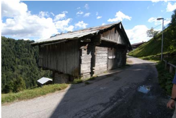
Foto 189: Costalta (San Pietro): Una tabià “a castello” con orditura della copertura “a correnti” e la presenza di un “arcareccio-banchina”, sostenuta dallo sbalzo della costruzione.
