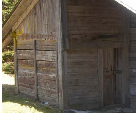
Foto 75: Prà del Belf (Val Vissdende): un ampliamento recente di un fabbricato “a castello” realizzato con la tecnica “a ritti e panconi”.
