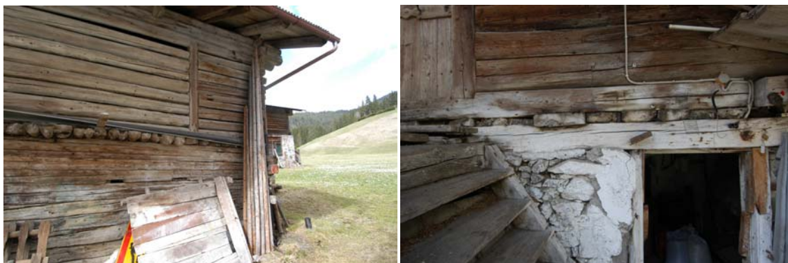
Foto 138 e 139: Costa d’Antola (Val Vissdende) e Sappada (Borgata Fontana): le teste dei pianci si fuoriescono dall’orditura della “struttura” “a castello”.
