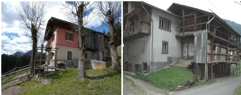
Foto 2 e 3: Costa d'Antola (Val Vissende) e Canale d'Agordo: nei due casi esposti il corpo anteriore, completamente in muratura, si differenzia da quello retrostante in legno.
