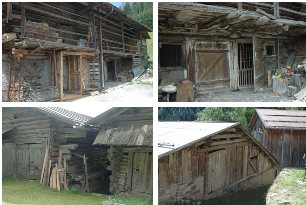
Foto 129: Immagini da Cogul (Vallada) e Bogo (Cencenighe): alcuni “tabià” della Valle del Biois. La muratura porta sempre fuori terra l’imposta della “struttura” in legno.
