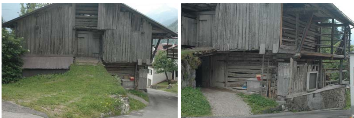
Foto 205: Piaz (Vallada): il “terrapieno” consente di raggiungere la quota del fienile al secondo livello; il “ponte” libera l’accesso al primo livello.
