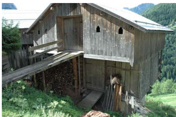
Foto 198 e 199: Pecol (San Tomaso) e Pianezze (San Tomaso): Generalmente si trova applicata a tipologie con almeno tre piani di utilizzo (stalla-fienile-fienile), mette in relazione il secondo livello, liberando l’accesso al primo livello sopra la stalla.
