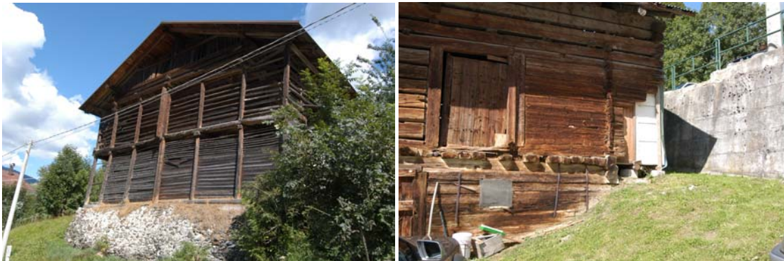
Foto 127 e 128: Casada (Santo Stefano) e Costalissoio (Santo Stefano): Un altro esempio di fondazione “a sentada”. Si noti il contrasto con le tipologie antiche della Valle del Biois, dove la struttura in muratura serviva a allineare le quote d’imposta delle parti lignee contro terra a monte (vedi le immagini successive) mentre, in questi esempi del Comelico, l’allineamento avviene in muratura sulle parti a valle, esasperando il concetto strutturale della “sentada”.
