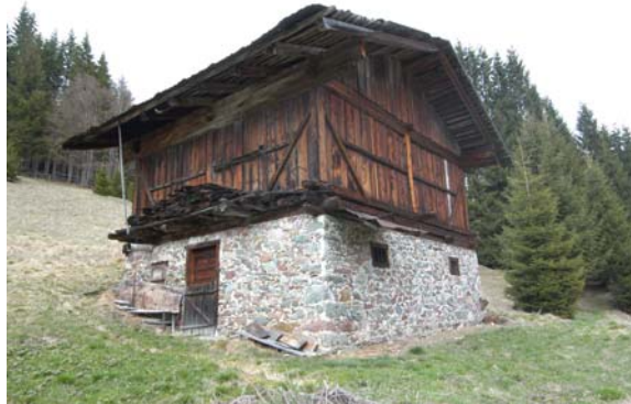
Foto 190: Costa d'Antola (Val visdende): l'orditura “a correnti” è presente anche nei tabià “a telaio”.
