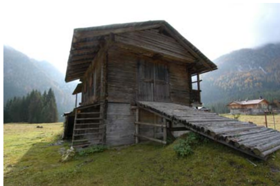
Foto 211: La Fratta (Val Visdende):i due tabià sono vicini; il primo mantiene inalterata la costruzione del “ponte-terrapieno”, il secondo ha trasformato la costruzione del “ponte-terrapieno” in un volume residenziale.
