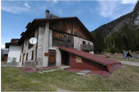
Foto 209 e 210: Cima Canale (Val visdende) e Costa d'Antola (Val Visdende): la costruzione “ponte-terrapieno” viene trasformata in “vano” abitabile (foto a sinistra), oppure viene utilizzata per realizzare alcune superfetazioni in aderenza (foto a destra).
