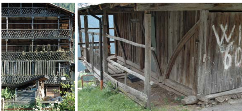
Foto 101: Canale d'Agordo e sulla destra Canacede: un tabià "a colonne" con anello inferiore legato "a castello" e controventatura con legni a curvatura naturale.
