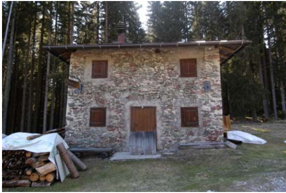
Foto 7: Prà del Belf in Val Vissende: la compagine muraria della facciata può rappresentare una “struttura/muratura con aperture” senza soluzioni di continuità nell'intero suo sviluppo
