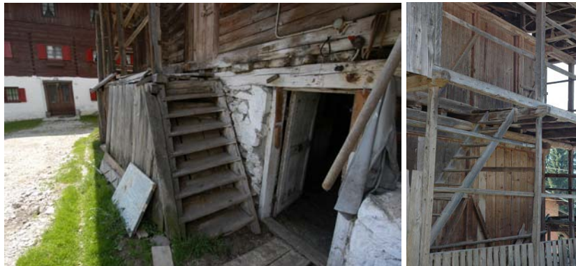
Foto 172 e 173: Sappada (Borgata Fontana) e Feder (Canale)
