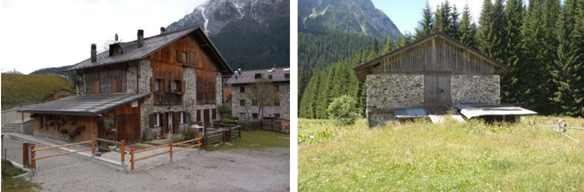
Foto 191 e 192: Costa d’Antola (Val visdende) e Piè della Costa (Val visdende): Due esempi di tetto “a terzere”: Il primo, riguarda un edificio tardo ottocentesco; il secondo vede una tipologia “a terzere” su capriate.
