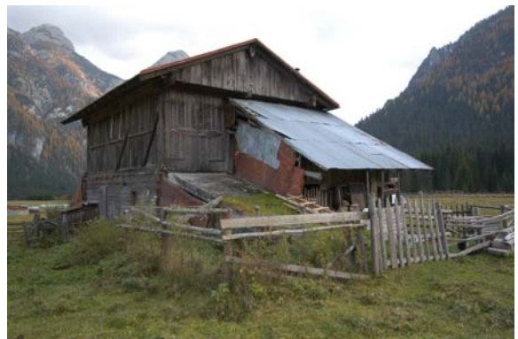
Foto 211: La Fratta (Val Visdende):i due tabià sono vicini; il primo mantiene inalterata la costruzione del “ponte-terrapieno”, il secondo ha trasformato la costruzione del “ponte-terrapieno” in un volume residenziale.
