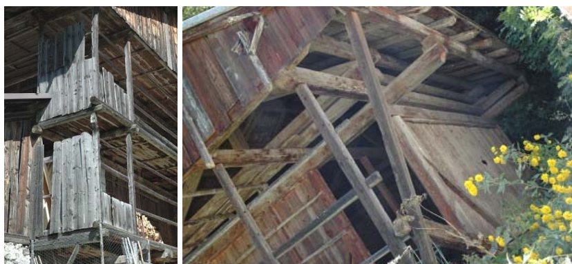
Foto 92 e 93: Un tabià “a telaio” e “a colonne” uno a Gares
