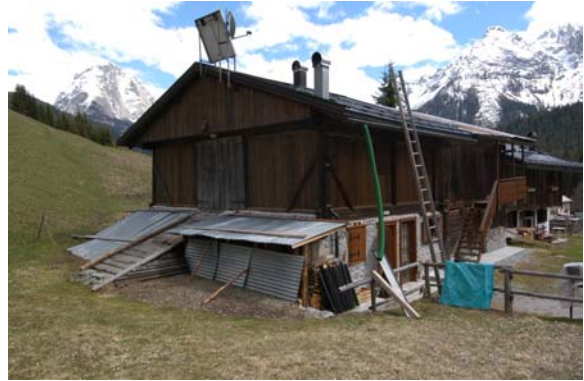
Foto 209 e 210: Cima Canale (Val visdende) e Costa d'Antola (Val Visdende): la costruzione “ponte-terrapieno” viene trasformata in “vano” abitabile (foto a sinistra), oppure viene utilizzata per realizzare alcune superfetazioni in aderenza (foto a destra).
