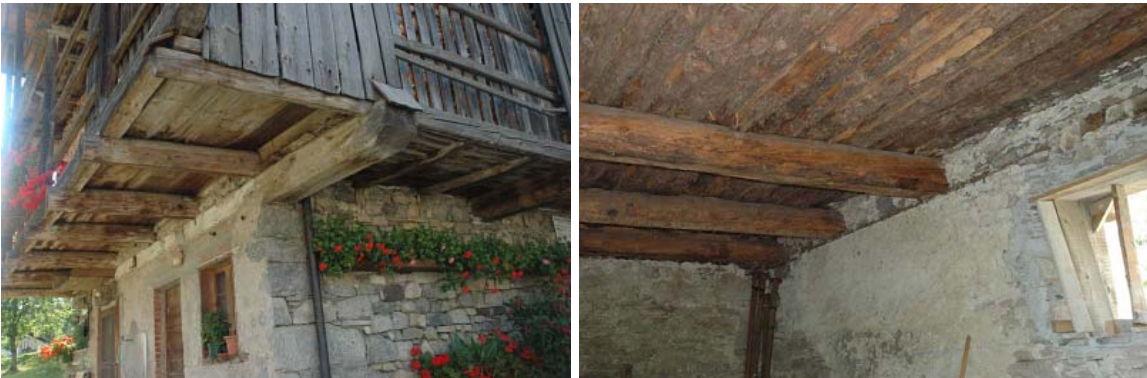
Foto 134: Celat (Vallada): solaio a doppia orditura: la prima, principale, realizzata con travi di dimensioni notevoli e posizionate ad interassi ampi; la seconda, organizzata perpendicolarmente alla prima, presenta sezioni delle travi inferiori e un interasse minore.
