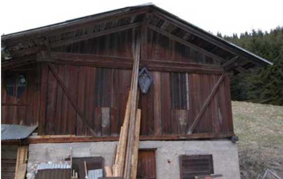
Foto 190: Costa d'Antola (Val visdende): l'orditura “a correnti” è presente anche nei tabià “a telaio”.
