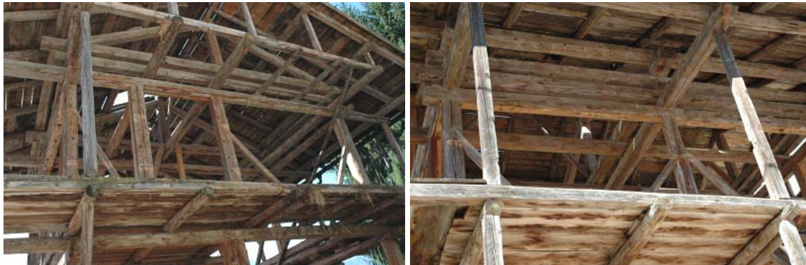
Foto 89: Il rilievo effettuato nella fase di smontaggio di questo tabià “a colonne controventate” in località “Feder”, consente di leggere le trabeazioni orizzontali a legni binati o trinati, legati “a castello” in corrispondenza degli spigoli.
