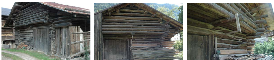
Foto 180: Celat (Vallada): Nei tabià più antichi l’orditura ad arcarecci è sostenuta da pareti “a castello”.
