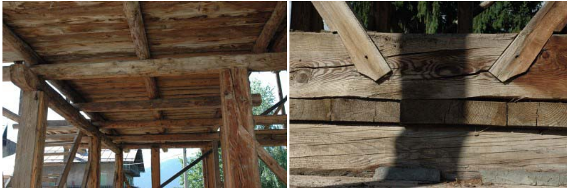
Foto 137: Feder (Canale): in questa struttura “a telaio”, si legge un solaio “a panconi” facilmente ispezionabile, in corrispondenza dell’ambiente della stalla. Nelle parti soprastanti non si riscontra più la doppia orditura orizzontale.
