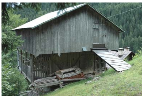
Foto 198 e 199: Pecol (San Tomaso) e Pianezze (San Tomaso): Generalmente si trova applicata a tipologie con almeno tre piani di utilizzo (stalla-fienile-fienile), mette in relazione il secondo livello, liberando l’accesso al primo livello sopra la stalla.
