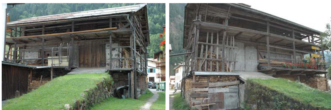
Foto 208: Canale d’Agordo: un tabià multifamiliare con gli accessi “terrapieno-ponte” al fienile contrapposti.
