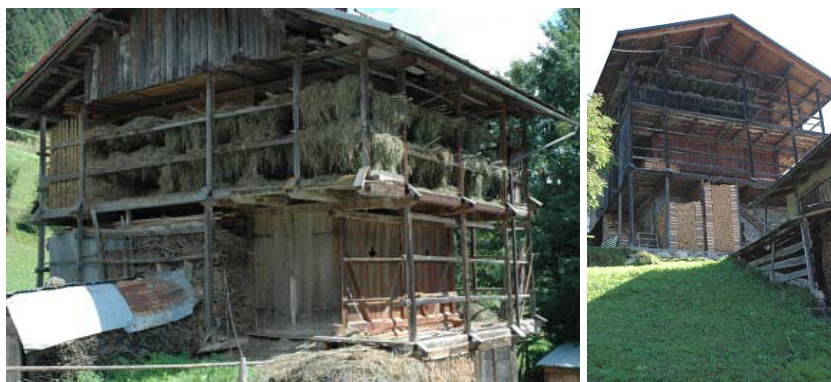
Foto 153 e 154: Fregona (Canale) e Feder (Canale): Struttura ballatoio” su due o più piani – edifici con struttura “a telaio”.
