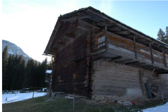
Foto 124: Prà Stavel (Val Visdende): fondazioni in pietra continue (“sentada”) per recuperare i dislivelli esistenti sull’intero perimetro.
