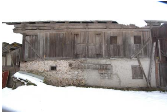
Foto 120: Prà della Fratta (Val Visdende): “Struttura” le cui fondazioni sono state realizzate con il semplice appoggio della muratura nel terreno. In questo caso la lettura della “struttura muratura” può comprendere anche la fondazione. L’eventuale necessità di distinguere parti diverse della muratura comporterà la delimitazione di “ambiti” di analisi, per le fondazioni, facilitati dall’individuazione della quota del piano orizzontale della pavimentazione.
