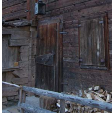
Foto 34: Si legge, in questo tabià do Prà Schiaron, un chiaro esempio di una parete aggiunta ad un corpo autonomo “a castello”: Una volta provveduto ad una rettifica della legatura angolare, si è partiti con la nuova struttura sul lato interno della legatura stessa.
