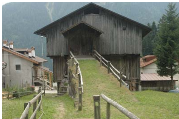
Foto 204: Sacchet (Vallada): il "ponte" è realizzato in panconi, tavole, tronchi o semitronchi, ecc, mentre il terrapieno è comunemente realizzato in pietrame facciavista.
