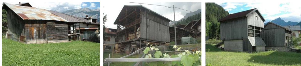
Foto 159, 160 e 161: Carfon (Canale), Cogul (Vallada) e Vare (San Tomaso)
