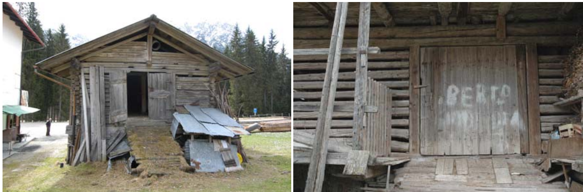
Foto 49 e 50: Costa d’Antola (Val Vissidena) e Canale: La descrizione del portone (dimensioni-ubicazione-ecc.) denuncia la funzionalità del piano di riferimento. L’analisi di dettaglio ne rileverà i singoli elementi costitutivi: dritti e travi – doppio anello di architrave ecc.
