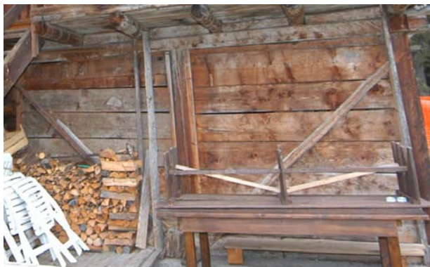
Foto 73: Fabbricato della Val Visdende (Costa Zucco), dove l'ampliamento eseguito sul fronte sud è stato realizzato, al piano terra, “a ritti e panconi”, sistema che ha consentito un agevole innesto sulla parete preesistente “a castello”.
