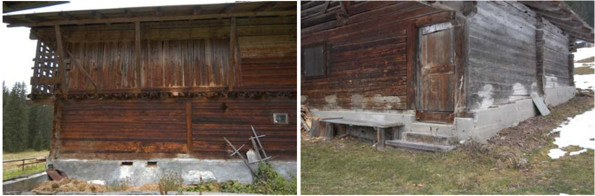
Foto 130 e 131: Costa Zucco (Val Visdende) e Prà Stavel (Val Visdende): “Strutture” di fondazione, in origine “a sentada”, alterate con interventi recenti. L’esempio rende evidente la necessità di leggere separatamente la “struttura” “fondazione” dalla “struttura” in elevazione.
