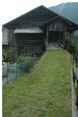
Foto 204: Sacchet (Vallada): il "ponte" è realizzato in panconi, tavole, tronchi o semitronchi, ecc, mentre il terrapieno è comunemente realizzato in pietrame facciavista.
