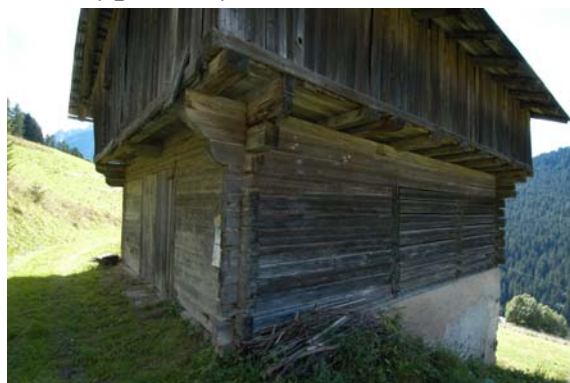
Foto 141: Esempio di solaio a sbalzo del sottotetto (“penizo”)
