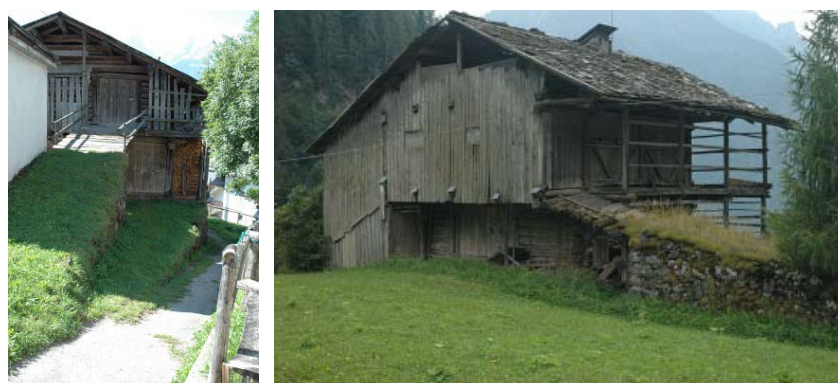
Foto 206 e 207: Feder (Canale) e Andrich (Vallada): nella foto a sinistra si evidenzia una costruzione mista: “Terrapieno” al primo livello; “terrapieno-ponte” al secondo. A destra: per salvaguardare il terreno falciabile il “terrapieno-ponte” è collocato sulla linea del cambio di pendenza, con l’accesso al fienile da ovest.
