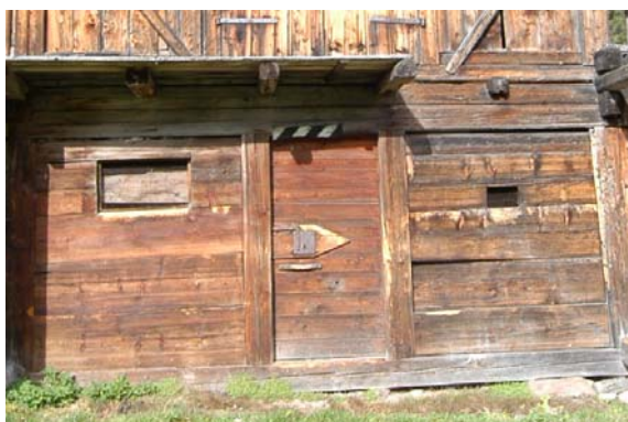
Foto 74: Prà della Fratta (Val Visdende): esempio di flessibilità costruttiva del sistema “a ritti e panconi”.
