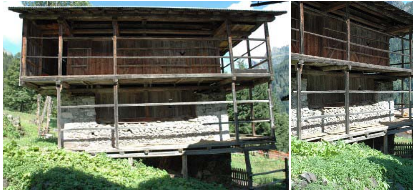
Foto 94 e 95: Un semplice esempio di una struttura "a telaio" su struttura in muratura (Gares)
