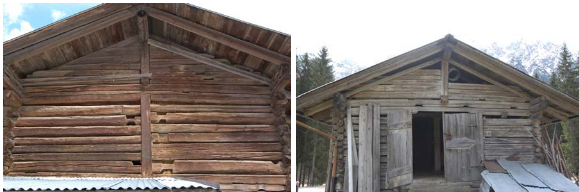
Foto 186: Costa d’Antola (Val Vissende): nei tabià “a castello” la parete si spingeva a sostegno del colmo e l’orditura era “a correnti” con l’andamento delle travi a “testa in giù”. I correnti, in corrispondenza della parete “a castello”, si alternavano interno-esterno.
