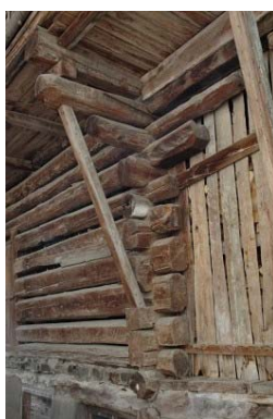
Foto 45: Canale: esempio dell'utilizzo di travi squadrate aperte
