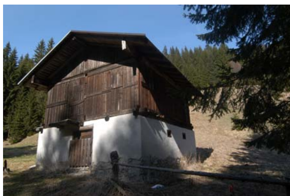
Foto 110: Prà del Belf – “Struttura” a telaio, tavole esterne, su corpo base in muratura.
