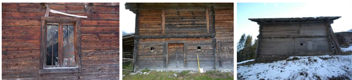
Foto 46, 47 e 48: Prà della Fratta, Prà Marino, Prà d Schiaron (Val Visdende): esempio dell'utilizzo di travi squadrate chiuse o combacianti
