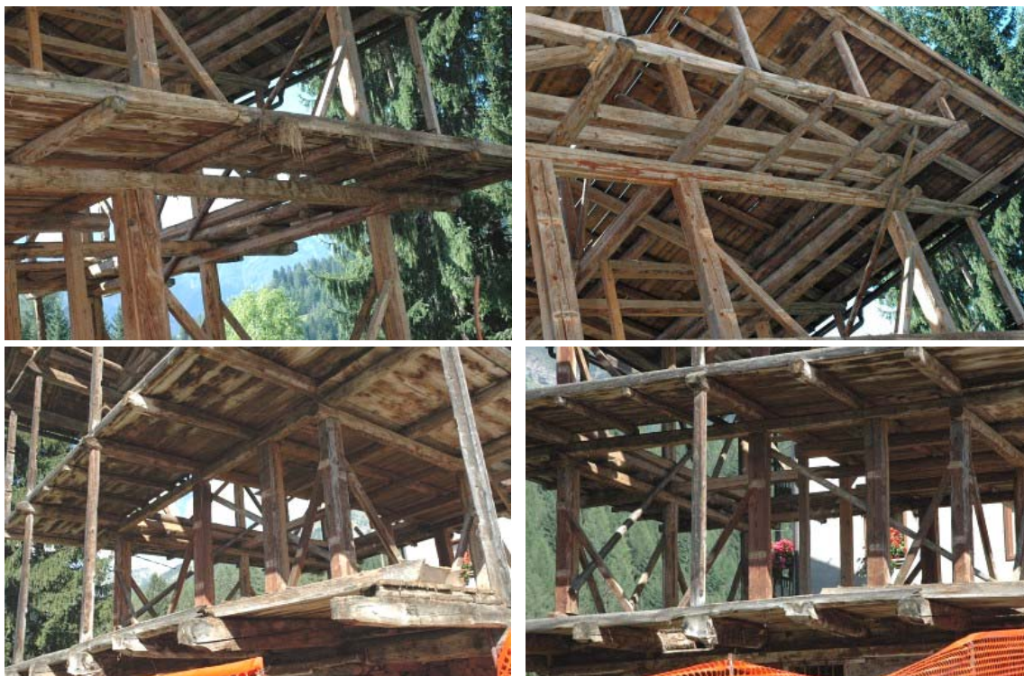
Foto 90: Le travi degli anelli escono a sbalzo per sostenere il ballatoio o una banchina supplementare.
