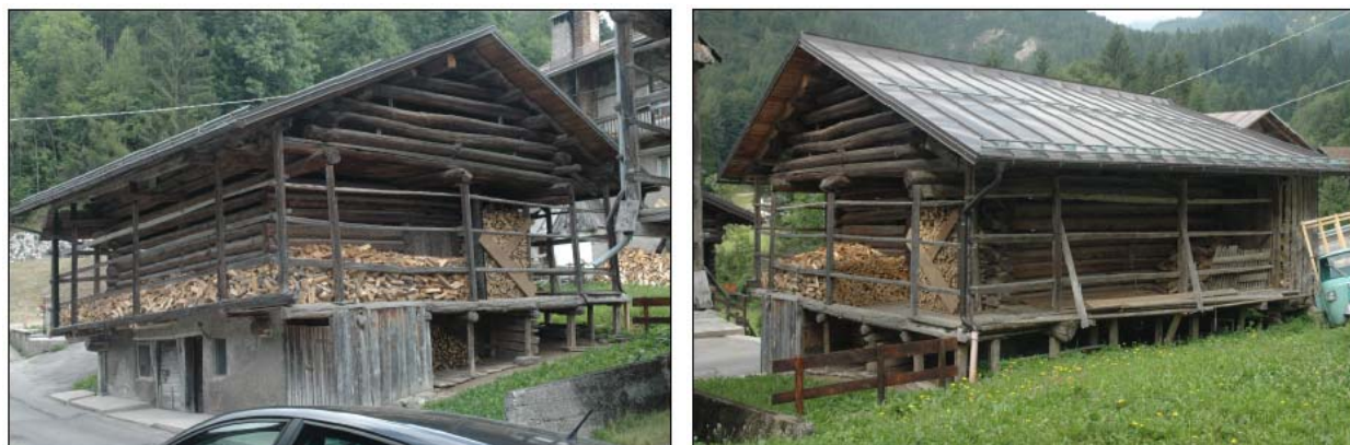
Foto 1: Stato di fatto del tabià visto rispettivamente da sud-ovest e da sud-est
