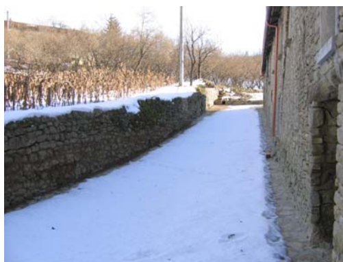
Vialetto su prospetto Nord Est
