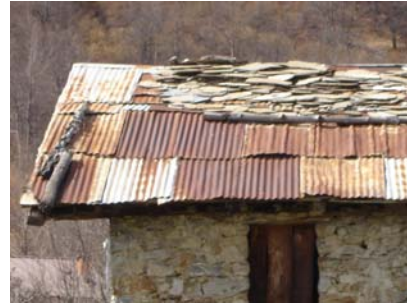
1 Falsi puntoni 20 cm 2 Arcarecci 10 cm 3 Lamiera 0,5 cm
