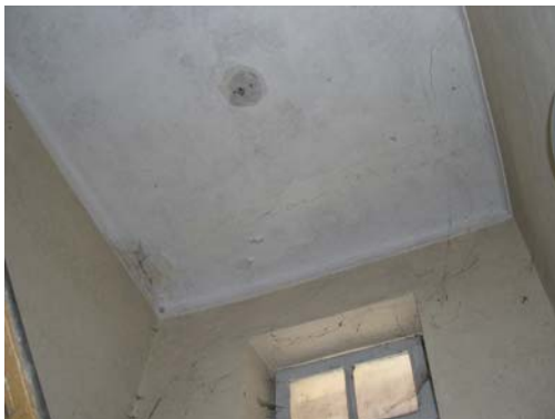
Particolare del soffitto
