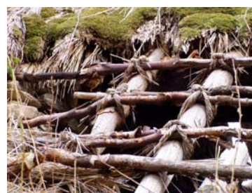
1 Travi in legno
