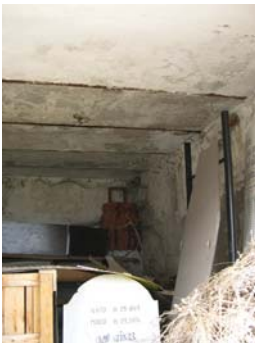
Particolari delle coperture
