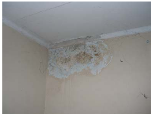
Particolare del soffitto
