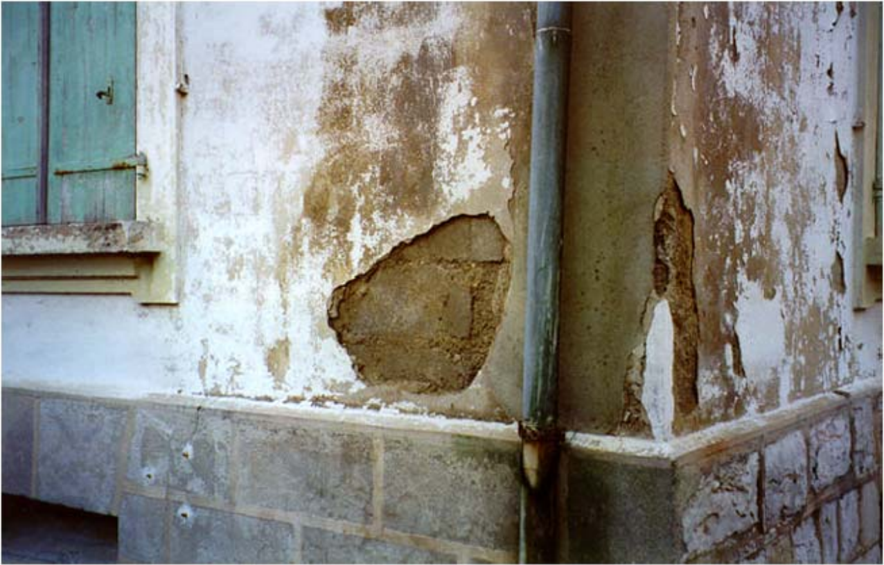
Facciata intonacata in codice D
